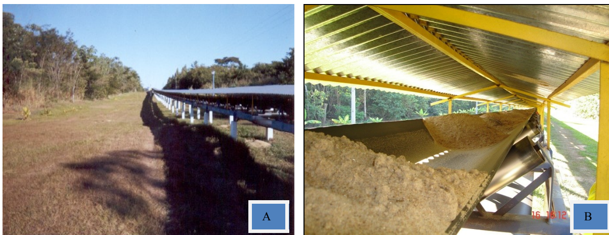
Figura 17 – Vista da esteira elétrica que leva a produção mineral ao segundo conjunto de silos finais, onde os caminhões são carregados. A : vista panorâmica da esteira, respeitando uma altura mínima do solo para forma um corredor para os animais transitarem entre os dois lados da mata; B : vista interna da extração transportando a produção de areia das margens do rio ao conjunto final de silos. Foto: (NERY DOS SANTOS, 2007)
