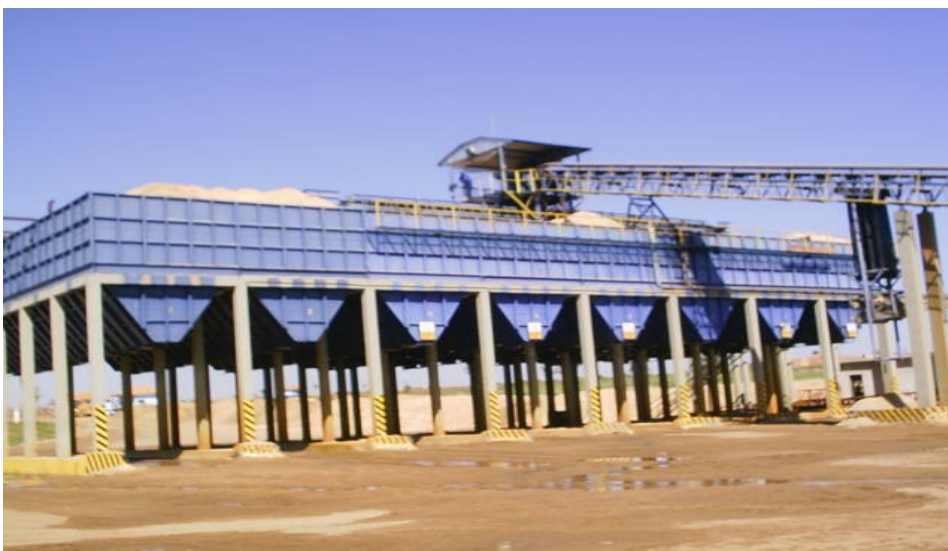
Figura 19 – Segundo conjunto de silos finais, fora da área da APP do rio Paraná. Foto: (NERY DOS SANTOS, 2007).
