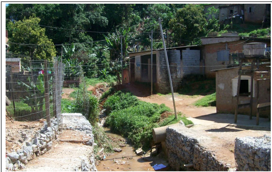
FIGURA 7. Lançamento de esgoto a céu aberto (Foto da autora. 11/2009).
