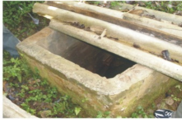
Vista do ponto 1 (nascente)
