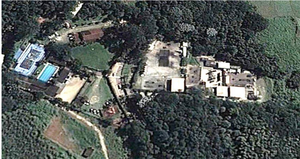
Figura 22: Equipamento Particular referente a uma indústria (Phibro). Coordenadas: 23°22'57.32"S; 46°23'48.42" O (Fonte: Google Earth 2013).
