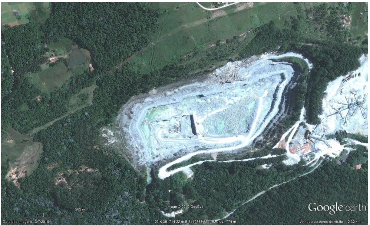
Foto 6: Mineração de granito (351714,22E / 7412733,70S)
