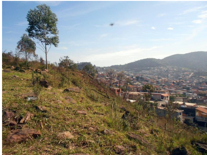
Figura 72 - Topo de talude de TAm com a presença de muito blocos de rocha metassedimentar. Tracejado aponta a cabeceira do escorregamento circular encontrado em área localizada ao final da rua Manoel Benevides de Almeida em trecho limítrofe do loteamento (foto de Vitorino, 2013).
