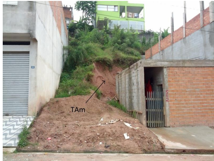
Figura 66 - TAm encontrado em talude de escavação no fundo do lote situado nº 562 na av. Nair de Oliveira Costa (foto de Vitorino, 2013).
