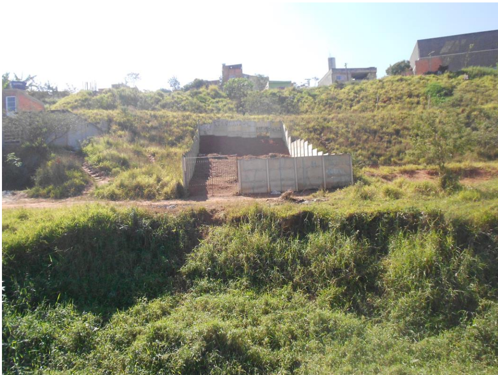
Figura 48 – Movimentação de terra por terraplenagem (VITORINO, 2014).
