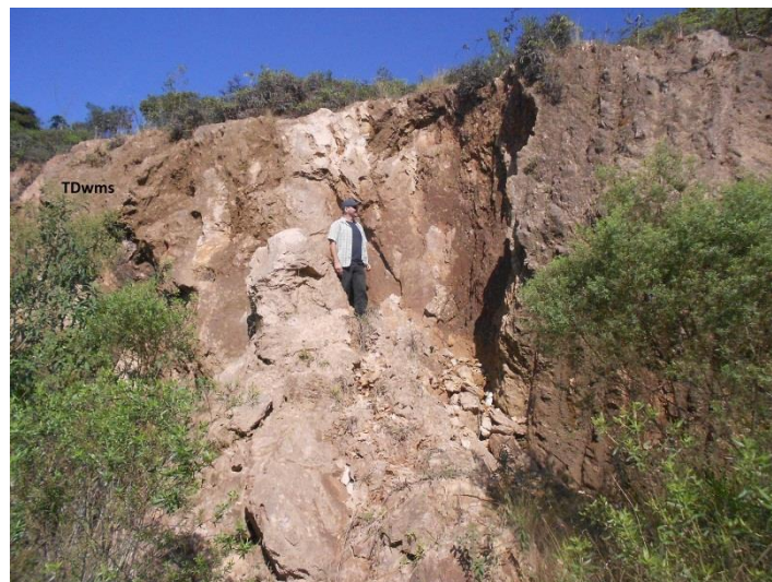
Figura 84 - TDwms em superfície de corte vertical demonstrando deslocamento. Área localizada na rua Manoel Benevides de Almeida em trecho limítrofe do loteamento (foto de Vitorino, 2013).
