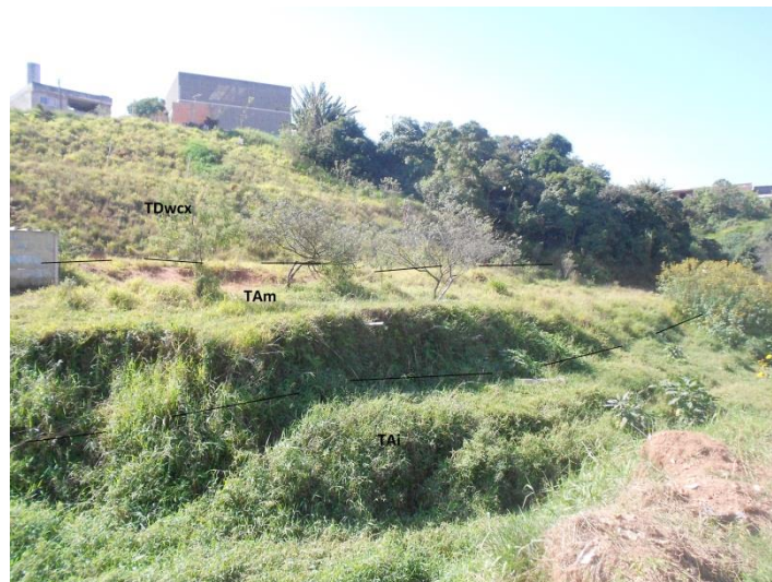
Figura 87 - TDcx em taludes escalonados onde estão situados lotes de uma quadra localizada entre a av. João Colado e a rua Roberto Magalhães (foto de Vitorino, 2013).
