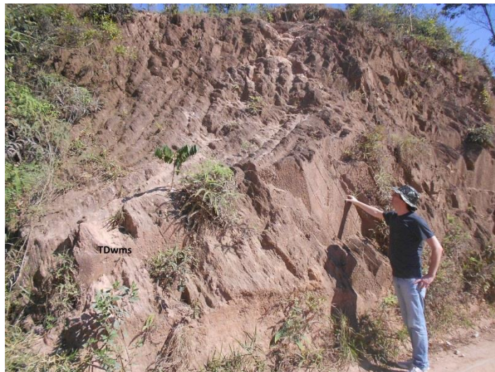
Figura 80 - TDwms em talude de corte no topo do morro que expõe planos de clivagem sub-verticais formando cunhas. Área localizada na rua Manoel Benevides de Almeida em trecho limítrofe do loteamento (foto de Vitorino, 2013).
