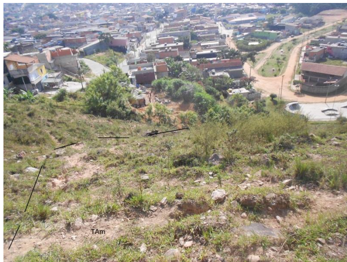
Figura 74 - Topo de talude de TAM. Tracejado aponta a cabeceira do escorregamento circular encontrado em área localizada ao final da rua Manoel Benevides de Almeida em trecho limítrofe do loteamento. Notar a presença de áreas de risco localizadas no setor da base (foto de Vitorino, 2013).
