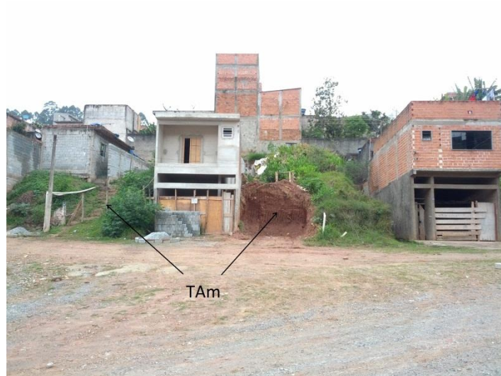
Figura 64 - TAm encontrado ao longo da rua Valdomiro Pereira Guimarães associado ao terço inferior da encosta e fundo de vale (foto de Vitorino, 2013).
