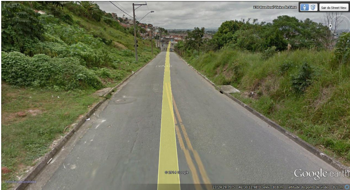
Figura 41: Ocupação residencial com alta densidade \leq 30\% ordenada com pavimentação. Coordenadas 23° 24' 29.70'' S; 46° 30' 12.98'' O (Fonte: Google Earth 2014).
