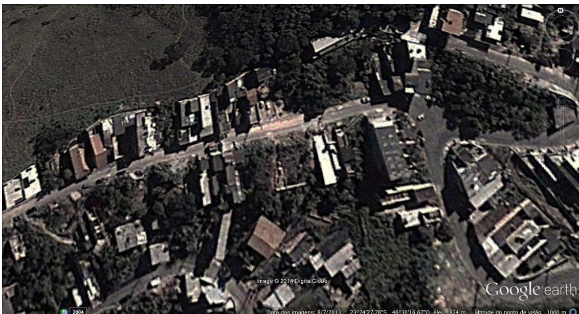
Figura 44: Ocupação Residencial com alta Densidade entre 30% e 70% e Ordenada com Pavimentação. Coordenadas 23° 24' 27.78'' S; 46° 30' 16.67'' O (Fonte: Google Earth 2014).
