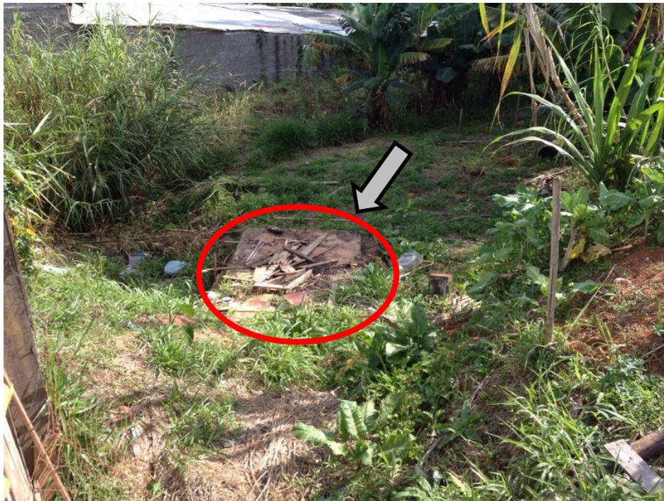
Figura 11: Segunda caixa de esgoto na nascente do Baquirivu. (Foto do autor)
