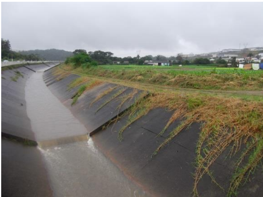
Figura 16: Sistema de canalização de seção trapezoidal do Rio Baquirivu em Áruja (Foto do autor).
