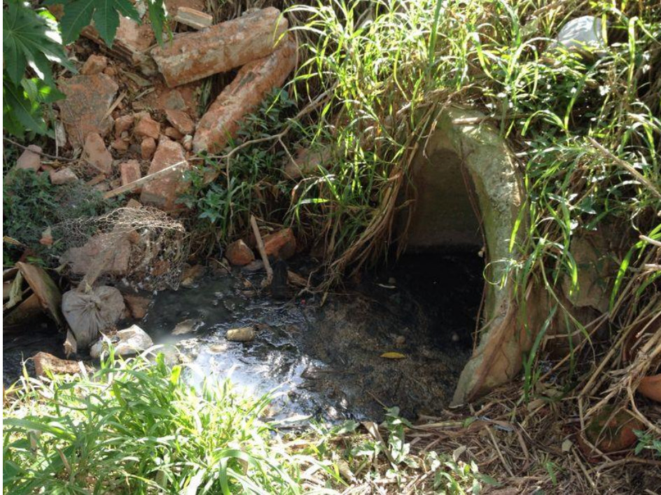
Figura 12: Final do sistema de canalização da nascente a montante do Baquirivu. (Foto do autor).
