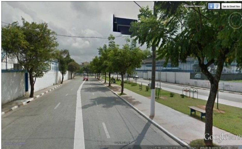
Figura 14: Rio Baquirivu após implantação do sistema de galeria fechada na Avenida Amazonas em Arujá (Google Earth 2014).
