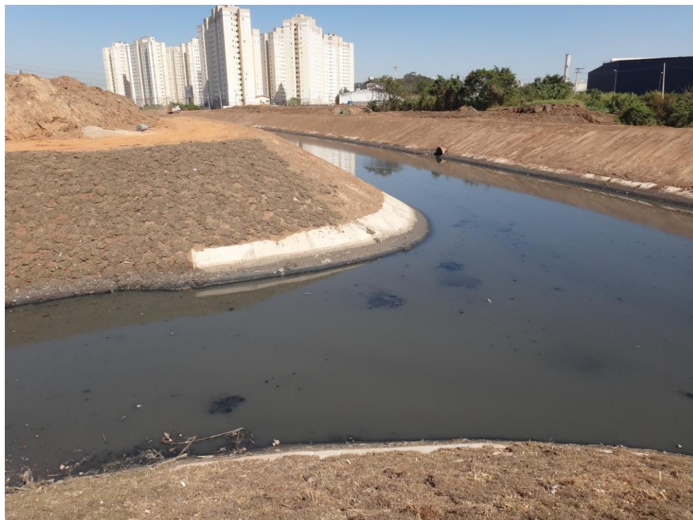
Figura 10.3 – Obra de retificação no Canal de Circunvalação, em vista a construção do reservatório de Contenção de águas da várzea no bairro da Ponte Grande. Foto: 29/12/2013 (acervo próprio).
