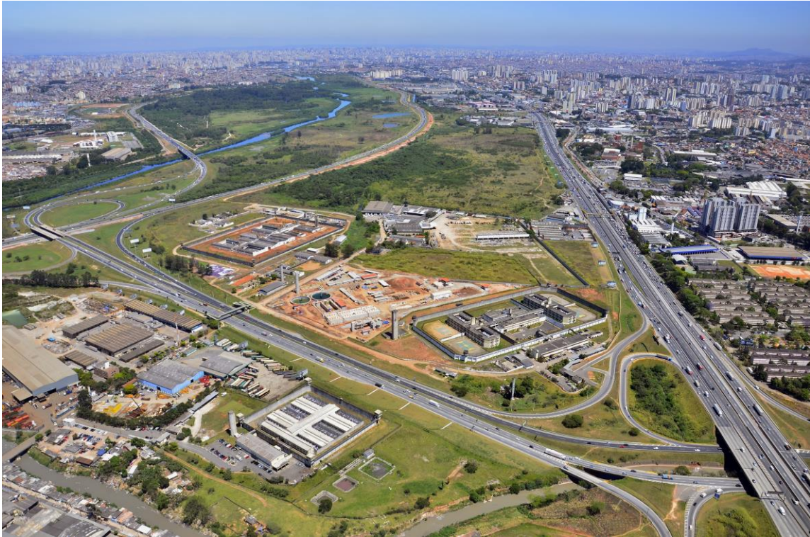
Figura 8.2 – ETE Várzea do Palácio (em obra) Fonte: GFAE-Goulart Fotografias Aéreas Ltda - 27/09/2013
