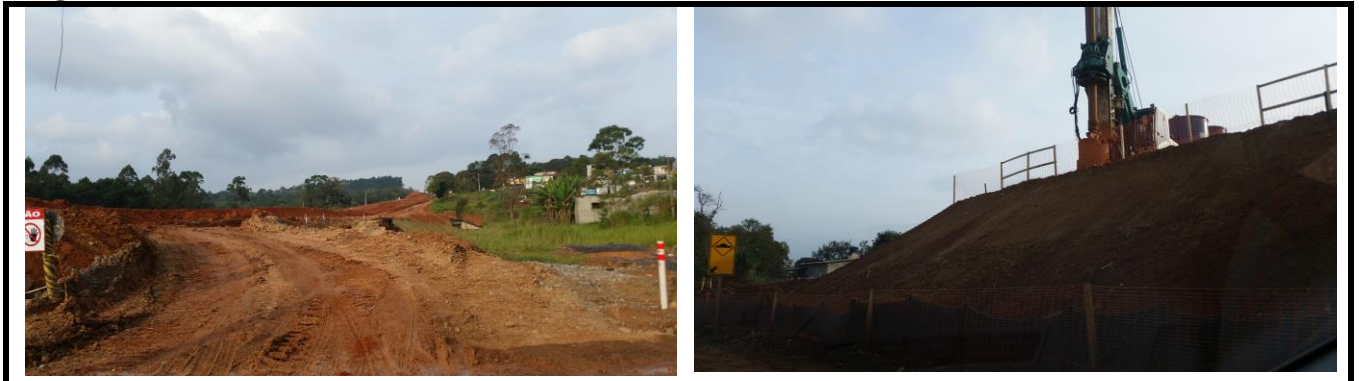
Figura 11. Obras do Rodoanel Mário Covas.
